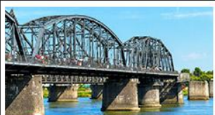
สะพานหวาดถานตง
