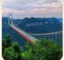
สะพานอ้ายจ้าย
